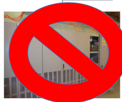
Système d'alimentation sans coupure
